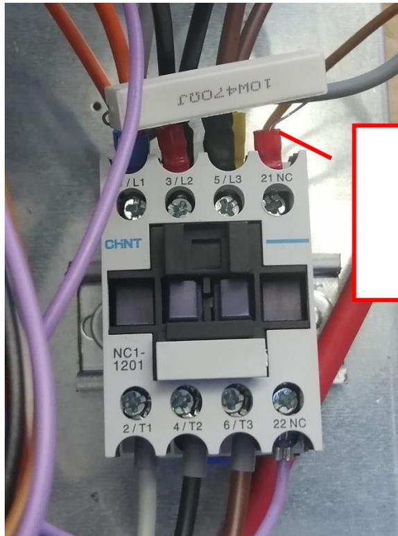
Vuelva a conectar la resistencia de cerámica en el contactor NC SIDE.
