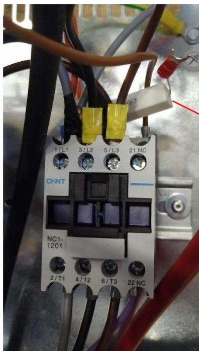
Desconecte la resistencia del contacto NC del contactor y fíjela con una brida de plástico.
